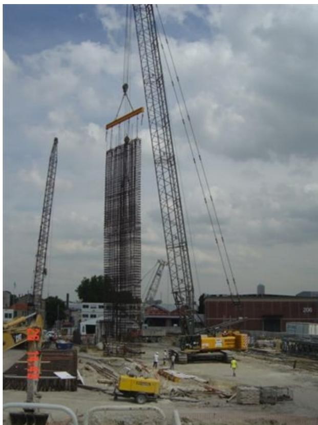
Figure 6 : Mise en place d'une cage d'armatures dans un panneau de paroi moulée
