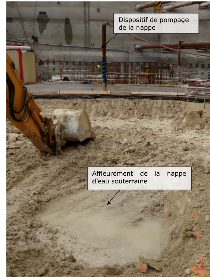
Figure 1 : Nappe d'eau souterraine affleurant lors de travaux de terrassement
