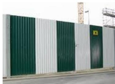
Bardage tôle de chantier standard
