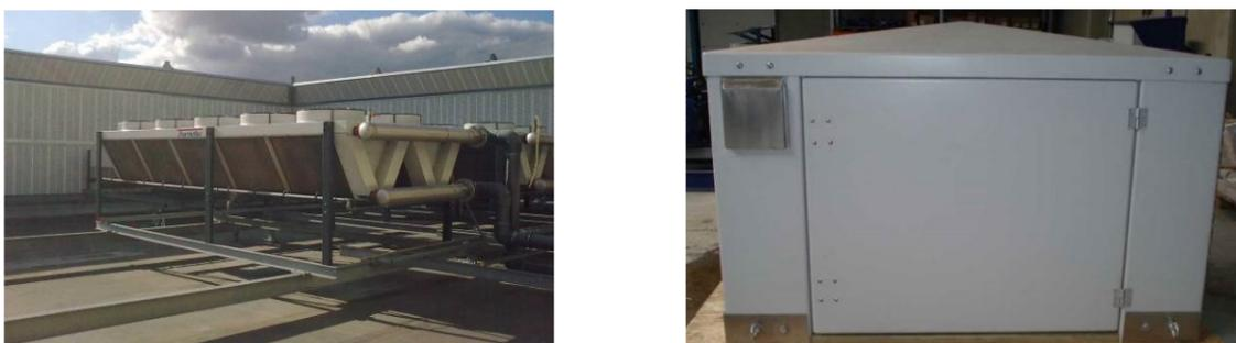
**Figure 4.8-15 : Exemples d'écran acoustiques et de capotage ventilé (source : ASM Acoustics)**
