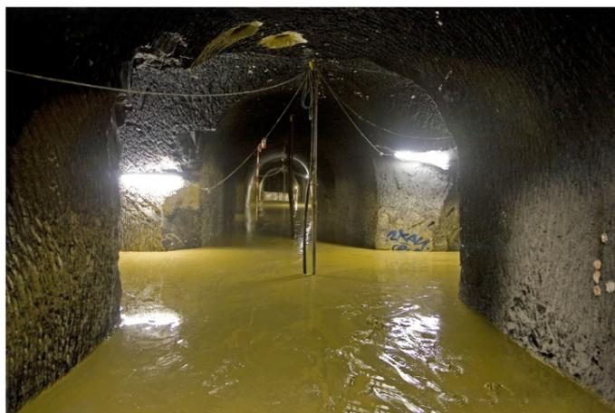
**Figure 4.1-3 : Illustration d'un remplissage de carrières (Source : SPIE)**
