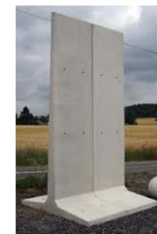
Mur anti-bruits en éléments béton préfabriqués
