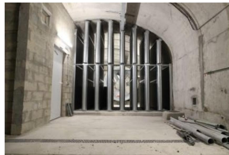
**Figure 4.8-13 : Exemple de silencieux intégré dans un rameau de ventilation (source : puits de ventilation ligne métro 4 - <http://www.rendezvousavecla4.fr>)**
